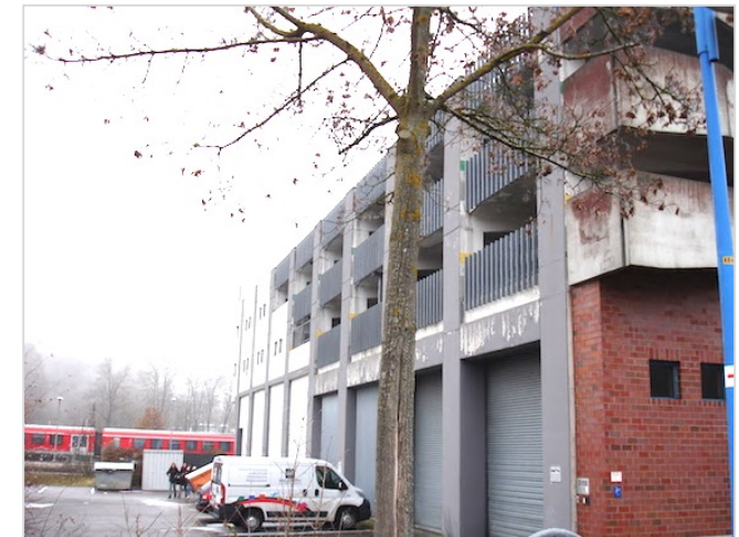
Blick auf Garageneinfahrten an nördlicher Gebäudeseite
