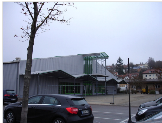
Blick auf leerstehenden Gartenfachmarkt (Projektareal)
